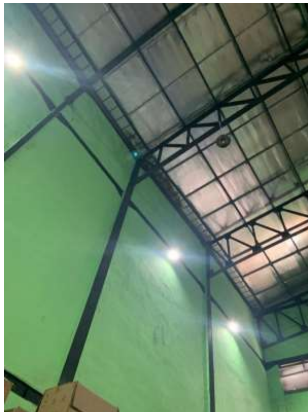
Gambar 9 Bagian Bangunan Dinding dan Atap Gudang
