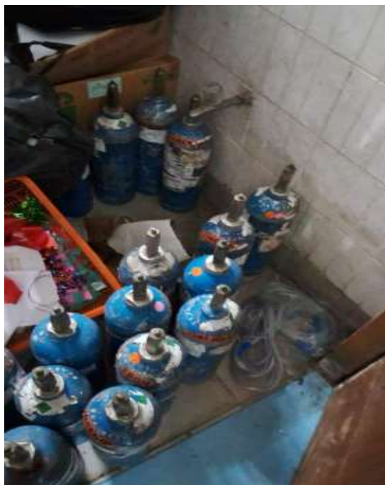
Gambar 10. Tempat penyimpanan gas medis N2O
