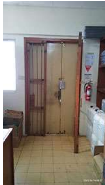
Gambar 2 Tampak dalam pintu Gudang Instalasi Farmasi RSPC
